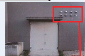
施工後 扉にガラリなし 密閉構造 右上部に 給気口追加
