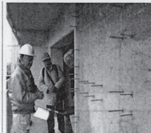
エレベーターホールの外壁に鉄筋コンクリートと鋼板をアンカーボルトで一体化し、耐震強度に優れた鋼板パネル耐震壁を施工している。
