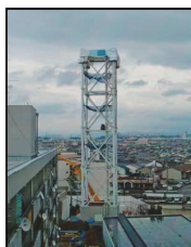
高架水槽架台 解体中
