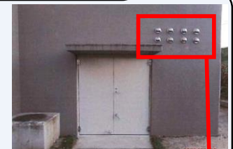
施工後 扉にガラリなし 密閉構造 右上部に 給気口追加
