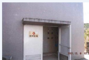
施工前 扉にガラリあり
