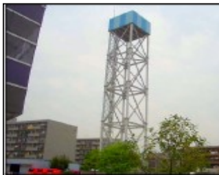
高架水槽 解体前
