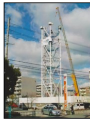
高架水槽架台 解体中
