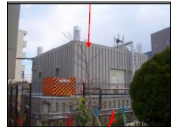
解体終了・地下室に 加圧給水設備集約
