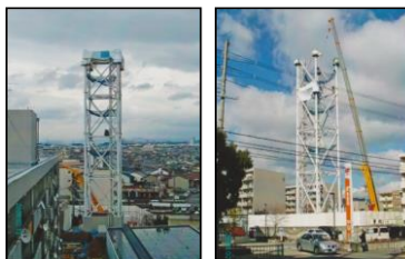
高架水槽架台 解体中
