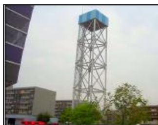
高架水槽 解体前
