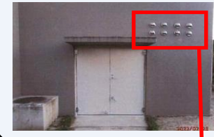
施工後 扉にガラクチなし 密閉構造 右上部に 給気口追加
