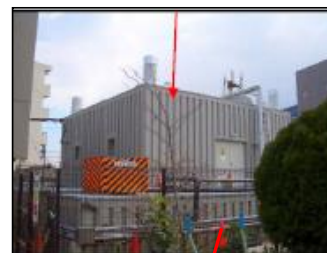
解体終了・地下室に 加圧給水設備集約
